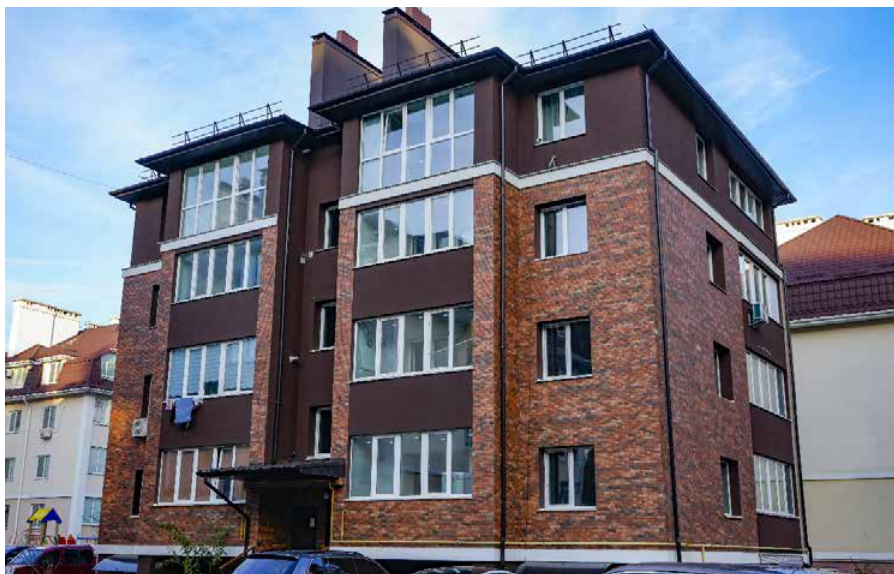
Житловий будинок в Ірпені по вул. Університетська, 2К. Після відновлення
