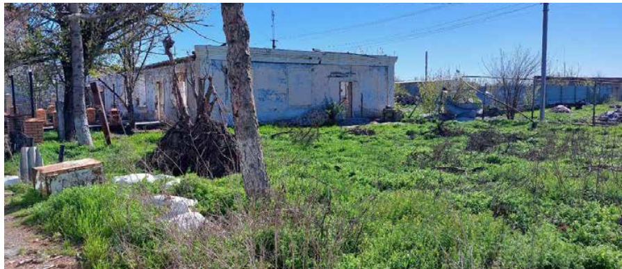
Зруйнована будівля сільської ради у селі Посад-Покровському. Фото станом на травень 2025 року
