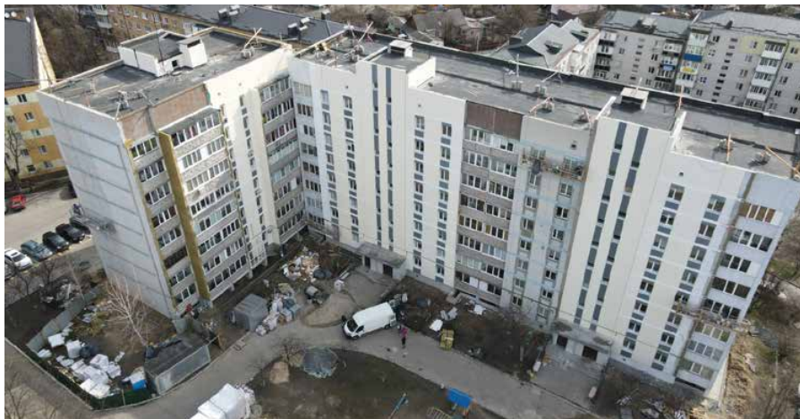
Житловий будинок по вул. Склозаводська, 5 у м. Бучі під час відновлення
