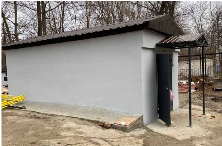
Вхід в укриття лікарні №10, Запоріжжя
