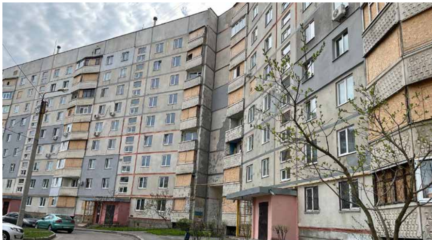
Багатоквартирний будинок на вулиці Дружби Народів, 267, Харків
