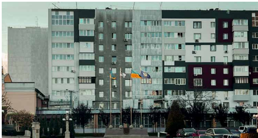
Житловий будинок в м. Ірпені по вул. Шевченка, 4 в процесі відновлення 106
